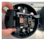
Rimozione del vano batteria.
