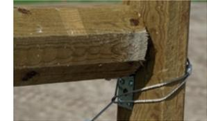
2. Befestigen Sie dann im zweiten Schritt den Zahnradrahtspanner mittels der integrierten Schlaufe ganz unten am Eckpfahl und fixieren Sie die Position mit Hilfe von einem Krampennagel.
