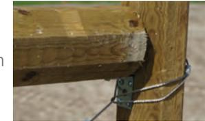
2. Befestigen Sie im zweiten Schritt das Edelstahl-Drahtseil mittels der integrierten Schleufe unten am Eckpfahl und fixieren Sie die Position mit einem Krampennagel.
