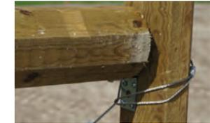
2. Befestigen Sie dann im zweiten Schritt den Zahnraddrahtspanner mittels der integrierten Schlaufe ganz unten am Eckpfahl und fixieren Sie die Position mit Hilfe von einem Krampennagel.
